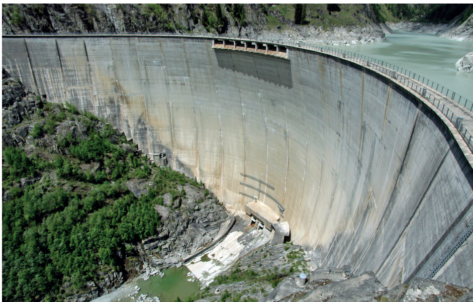
Il n'est pas facile de rehausser un barrage, car cela modifie fondamentalement sa géométrie.
